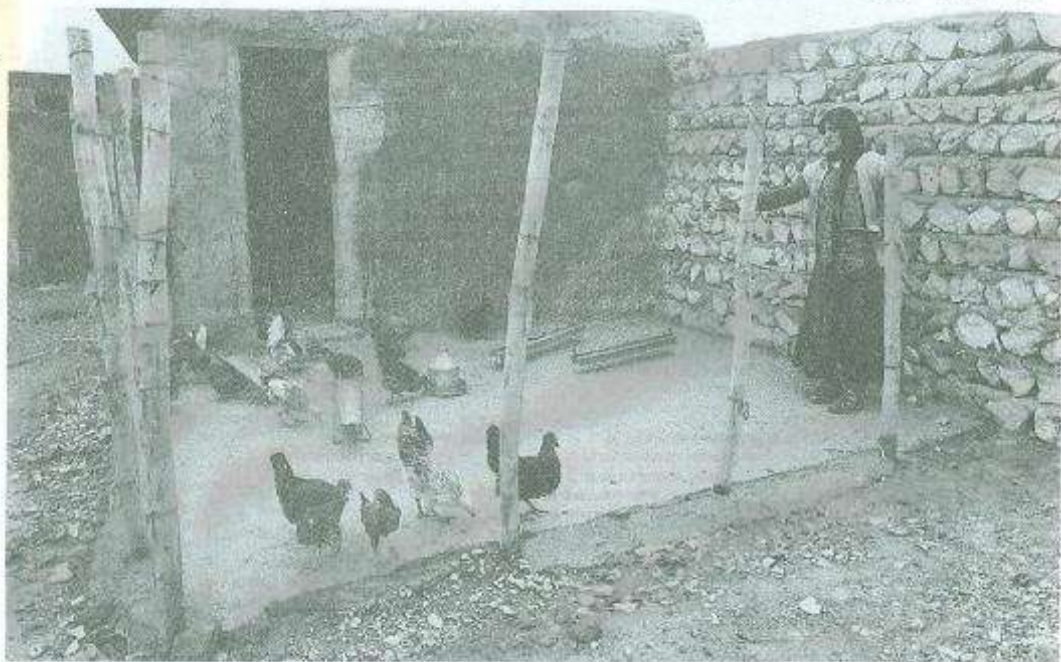
شکل شماره ۴- استفاده از سنگ و سیمان در ساختمان لانه، بهداشتی و مقرون به صرفه است
